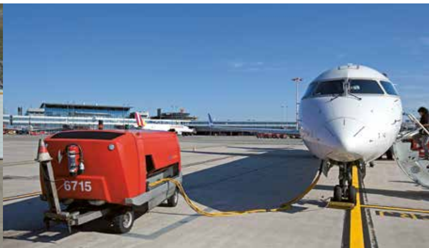
Mobile Bodenstromgeräte versorgen Flugzeuge an den Außenpositionen mit elektrischem Strom, so dass auch hier die APUs ausgeschaltet bleiben können
