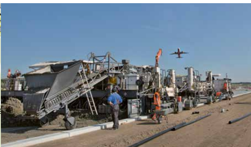
Erste Arbeiten im Bereich des Vorfeldes 1 Süd
